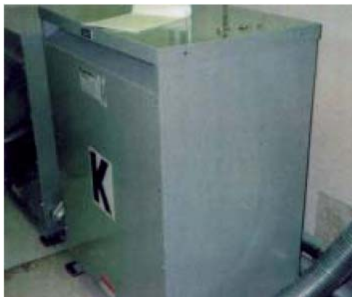
Figura 9: Transformador de interior de categoría K.
